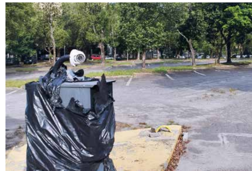
INOPERANTE Sistema de monitoramento na entrada não funciona
