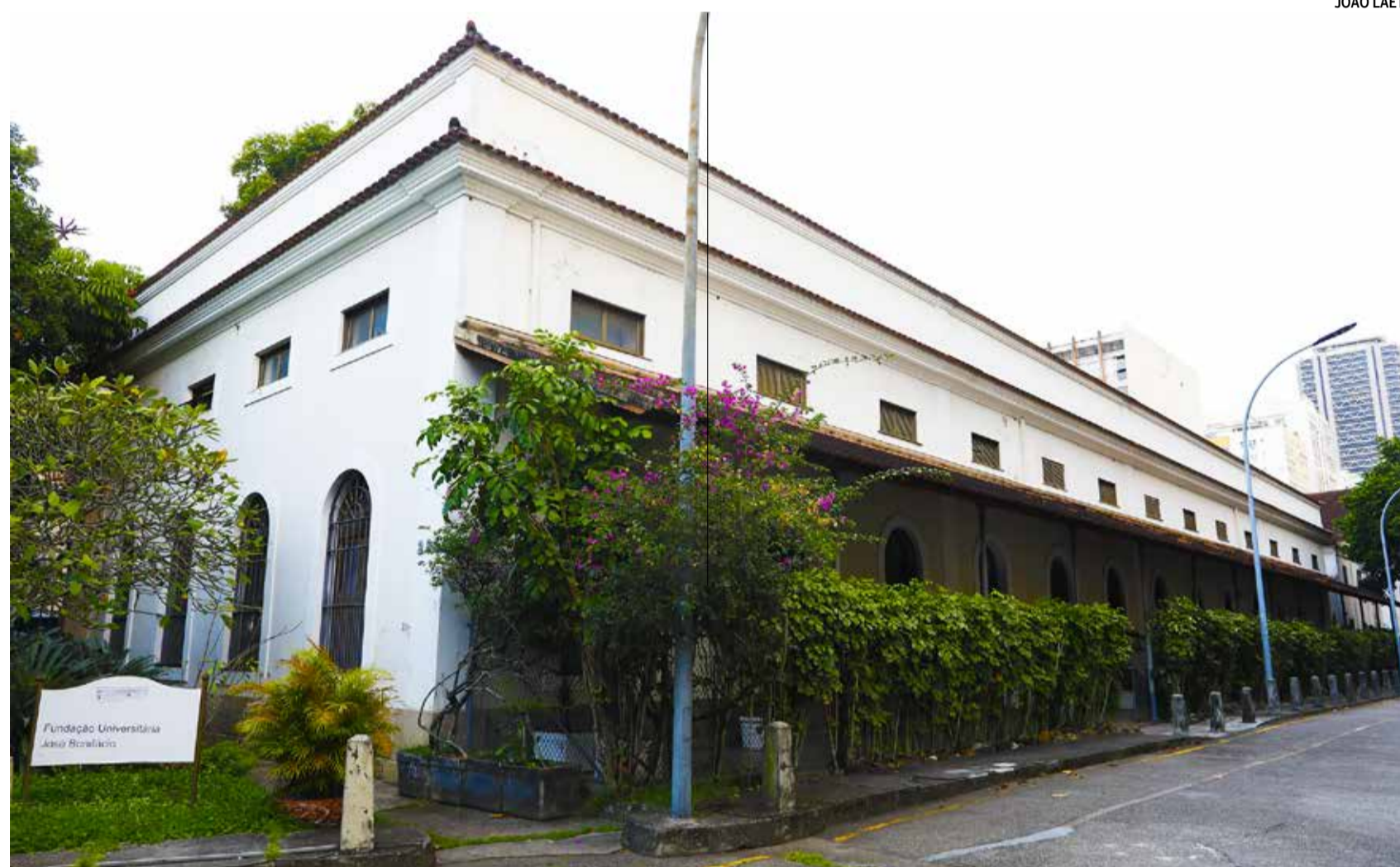
“NOVA FUJB” Entre as medidas adotadas pela diretoria está a criação de uma nova sede no Fundão. Acima, a atual sede da Praia Vermelha
