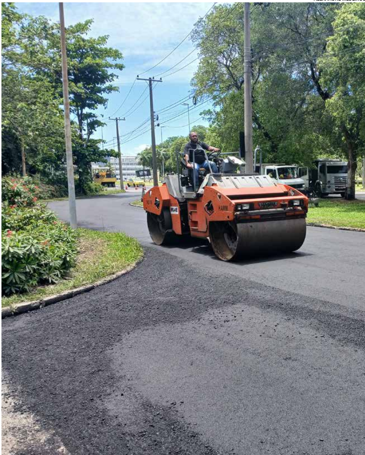
ALÍVIO As crateras que desafiavam a destreza dos motoristas que acessam o CT foram fechadas
