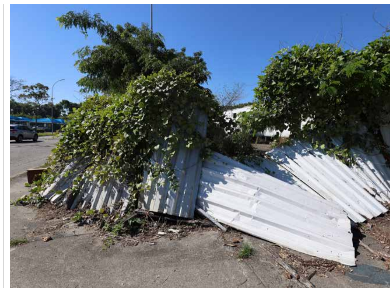
ABANDONO Estrutura interna tem infiltrações e as barreiras metálicas de proteção foram derrubadas
